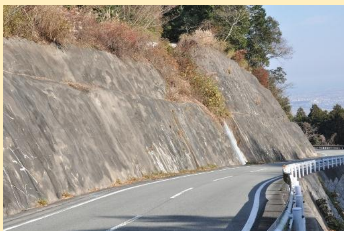
吹付けコンクリートの例
